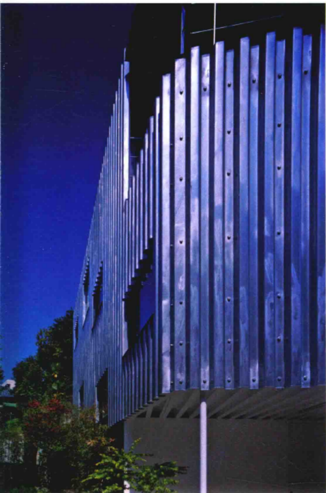
建筑外墙一角 Façade corner
