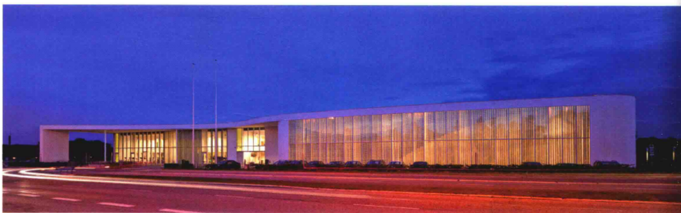
General view 全景图
