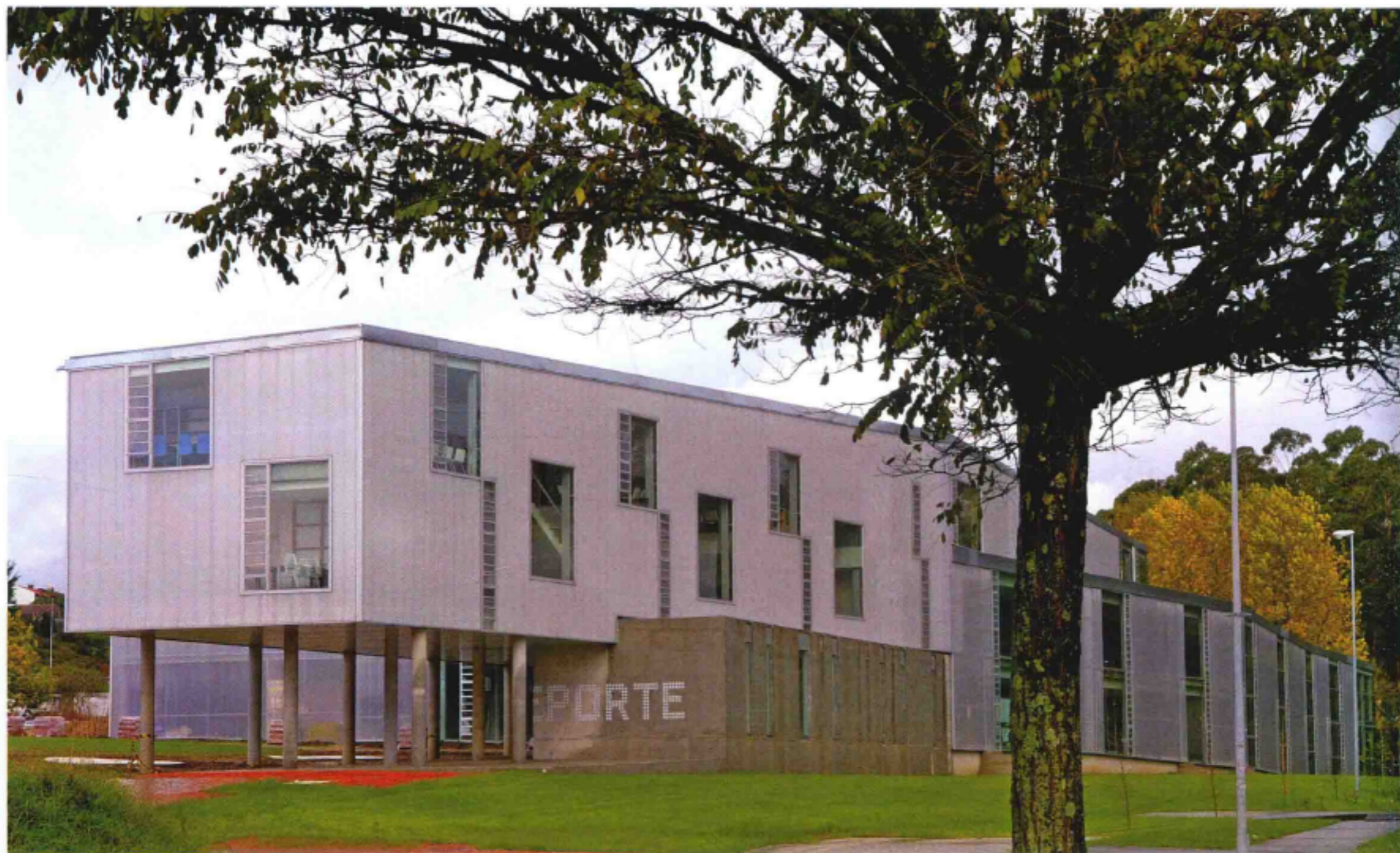
Façade 建筑外观
