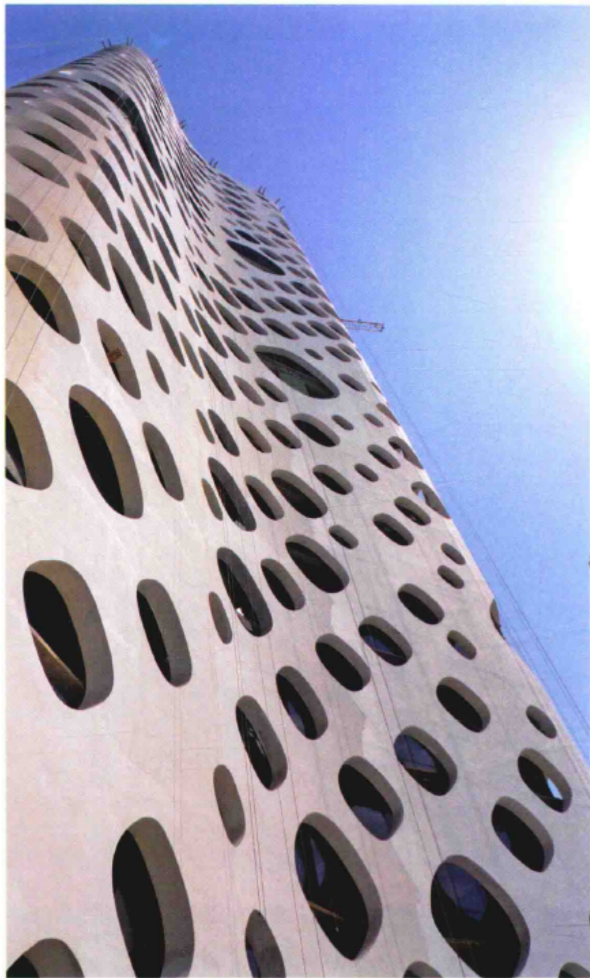
建筑外墙 Façade
