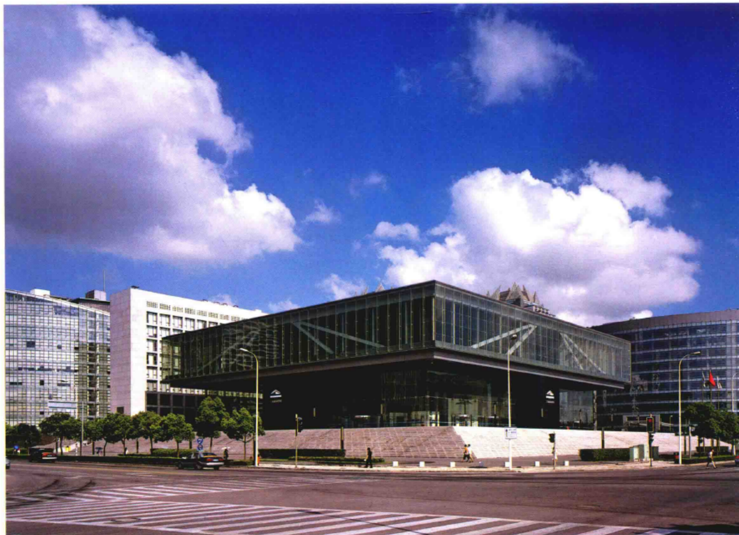
General view 全景图
