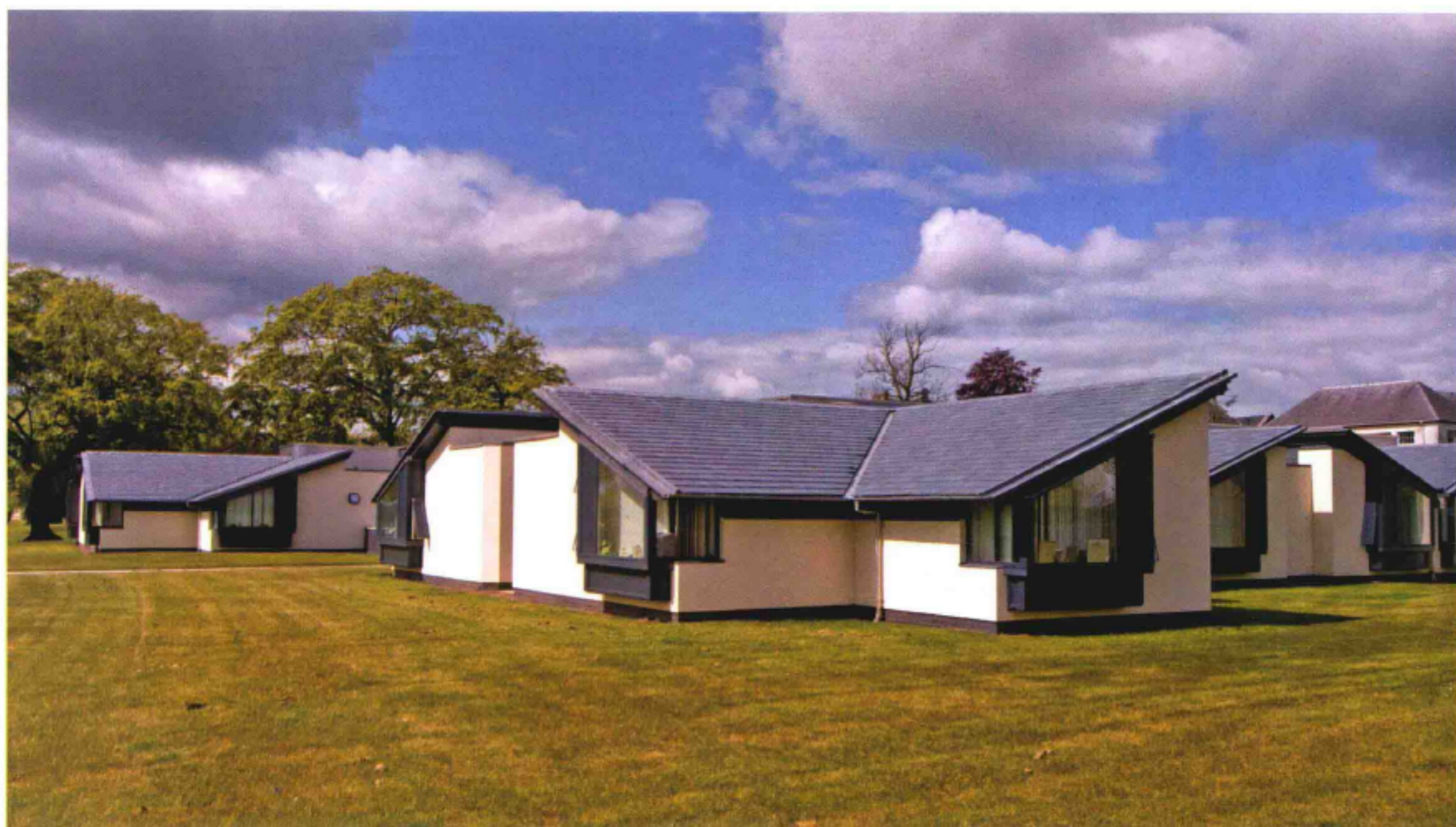
Exterior 建筑外观
