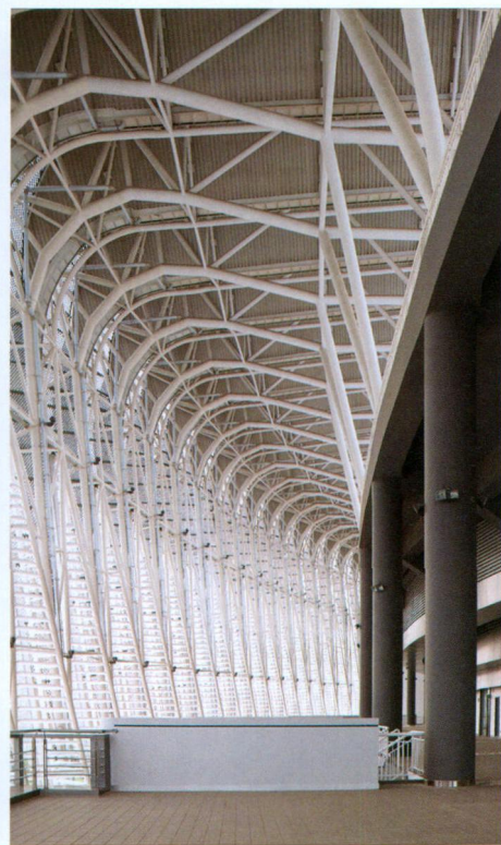
体育场罩棚钢结构柱廊
