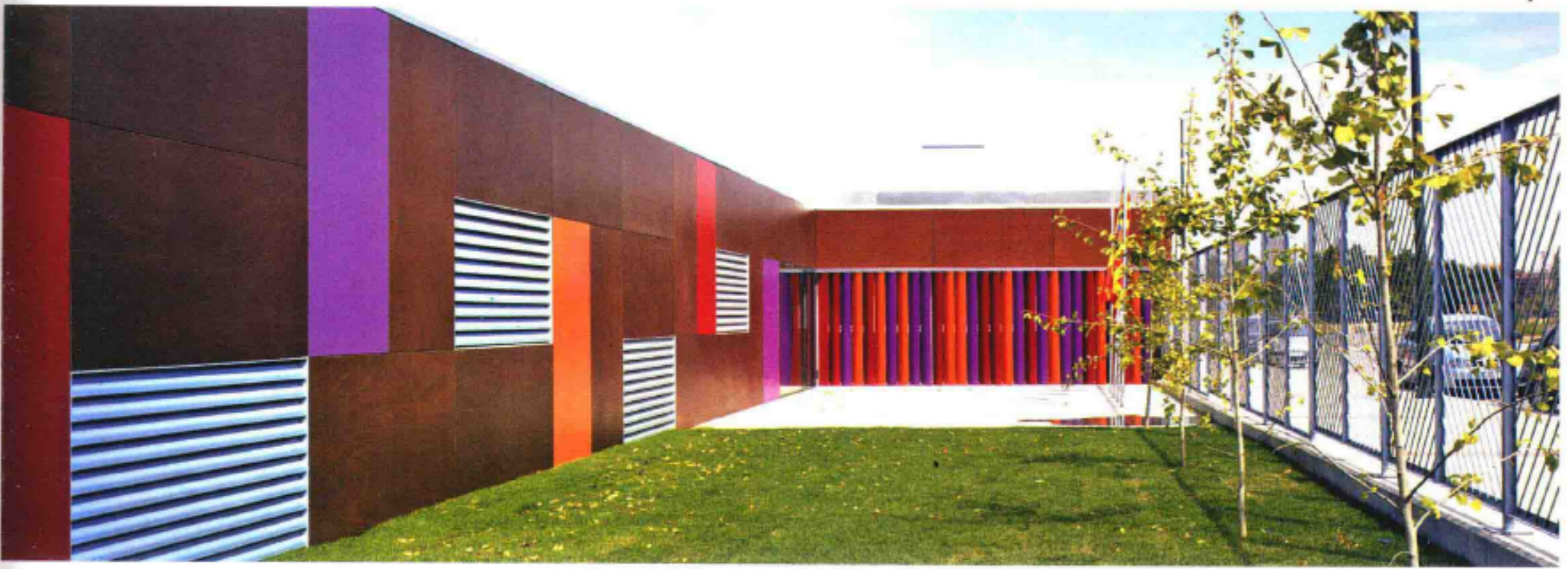
建筑外墙 Wall
