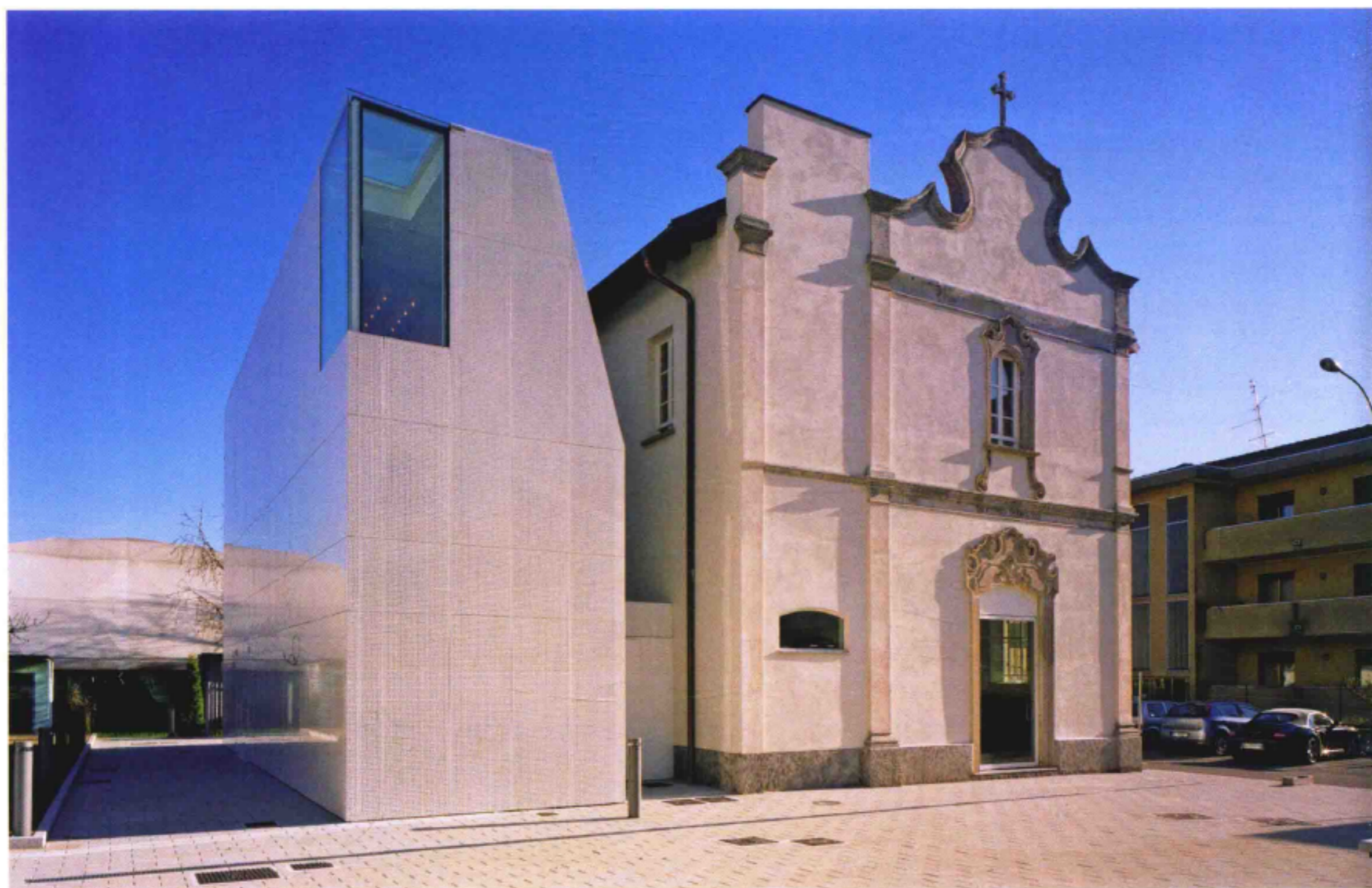
Front view 建筑正面
