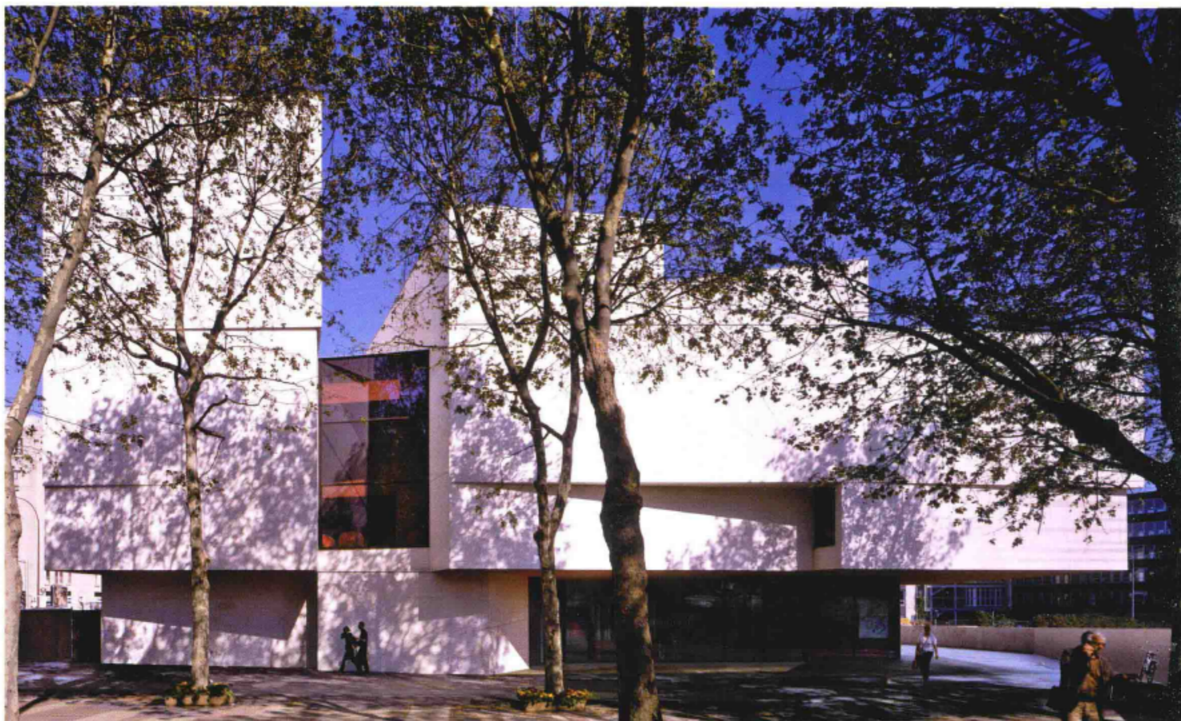
General view 全景图
