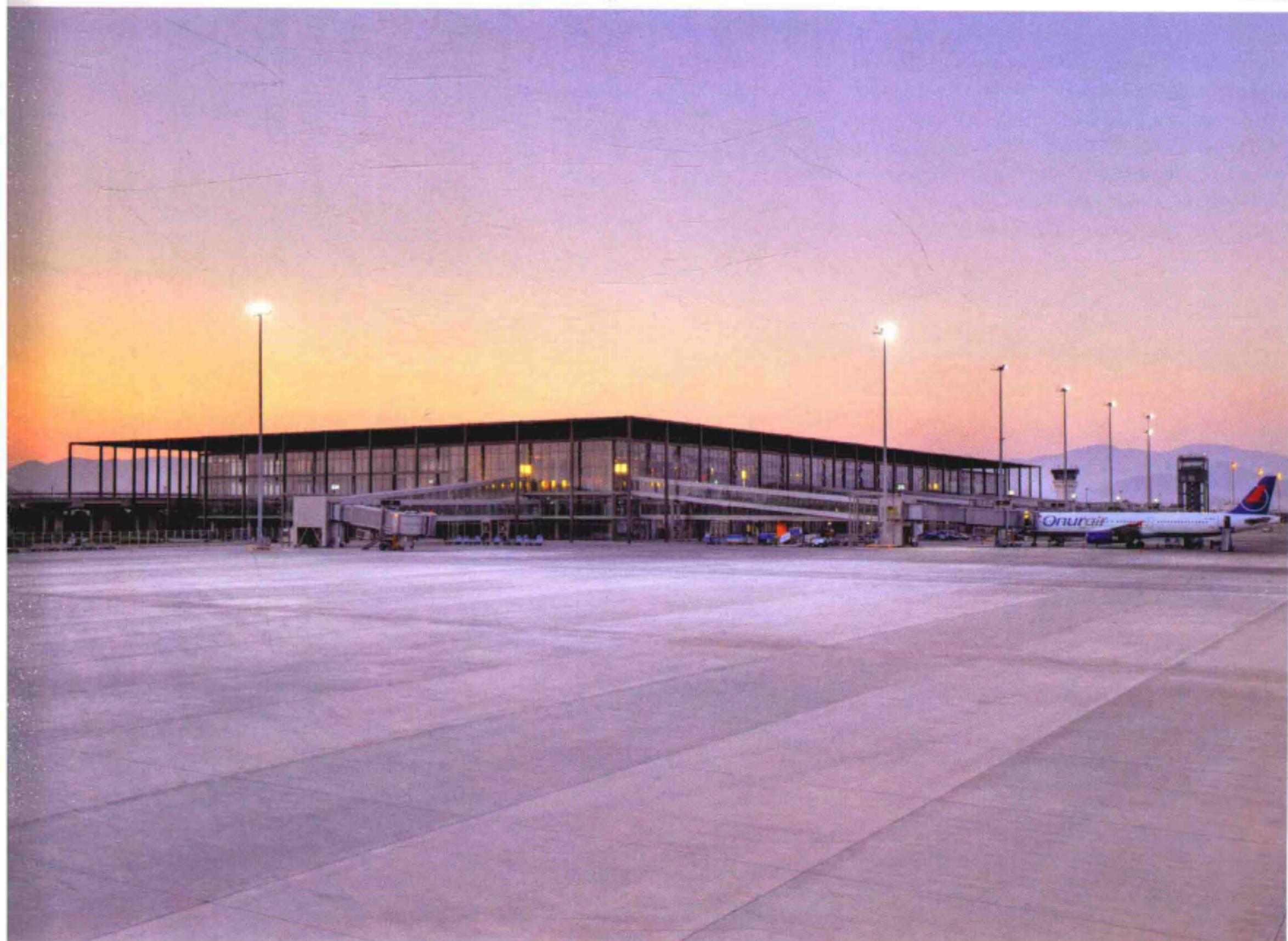
建筑背面 Back view
