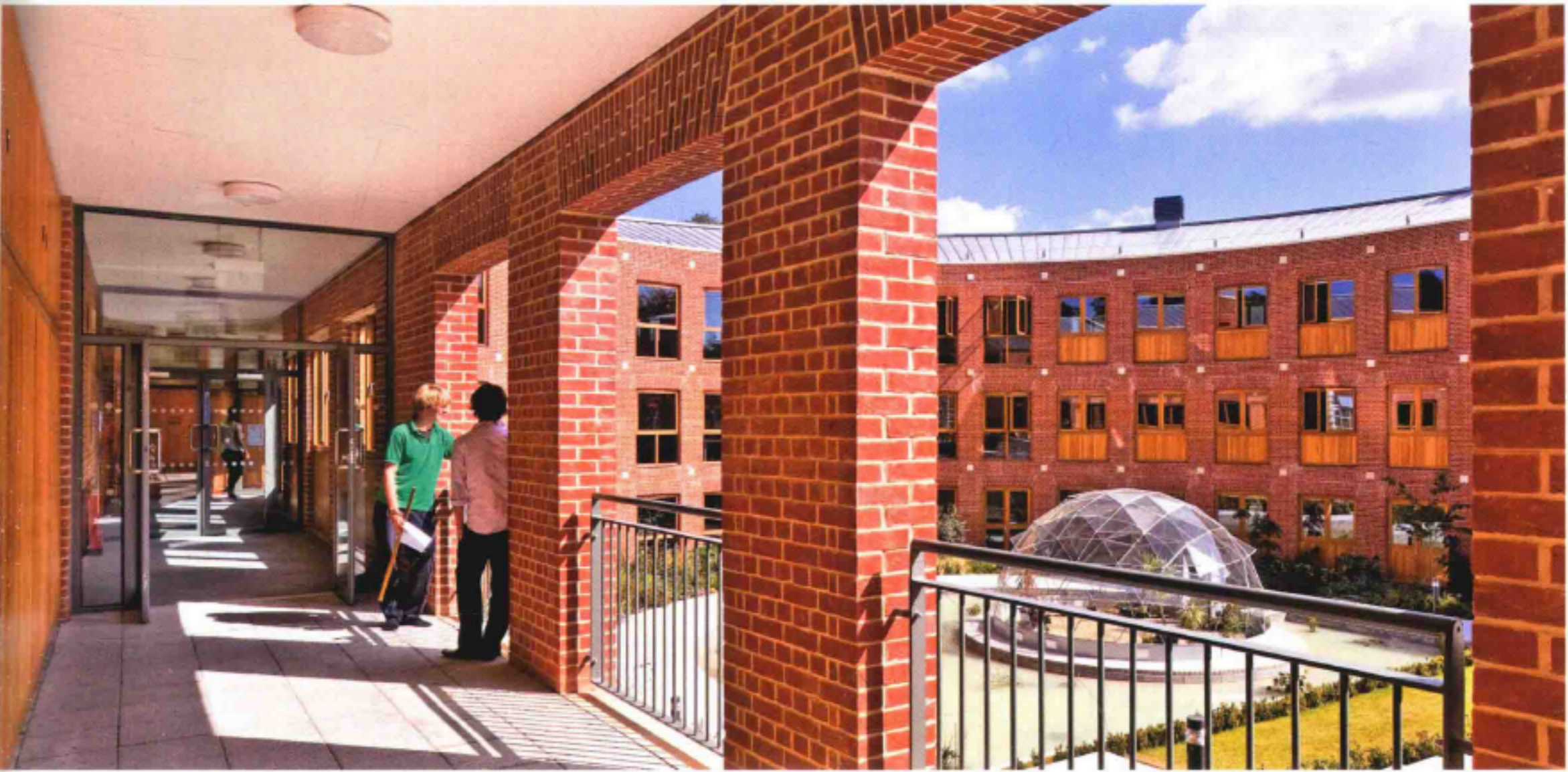
外部走道 External walkway
