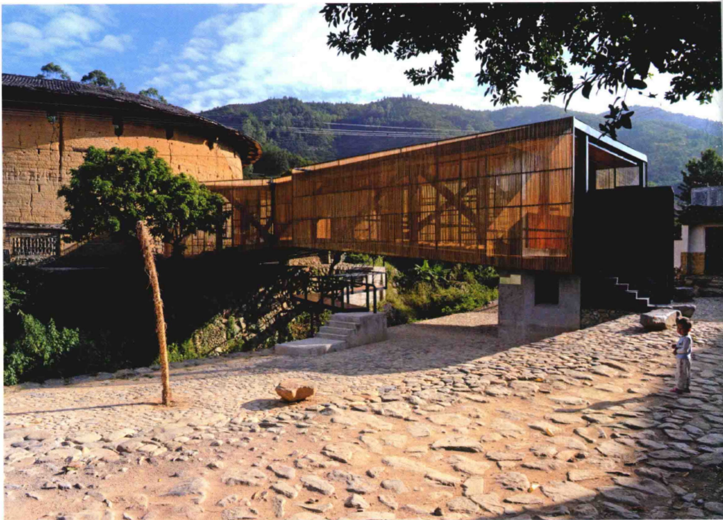
General view 全景图
