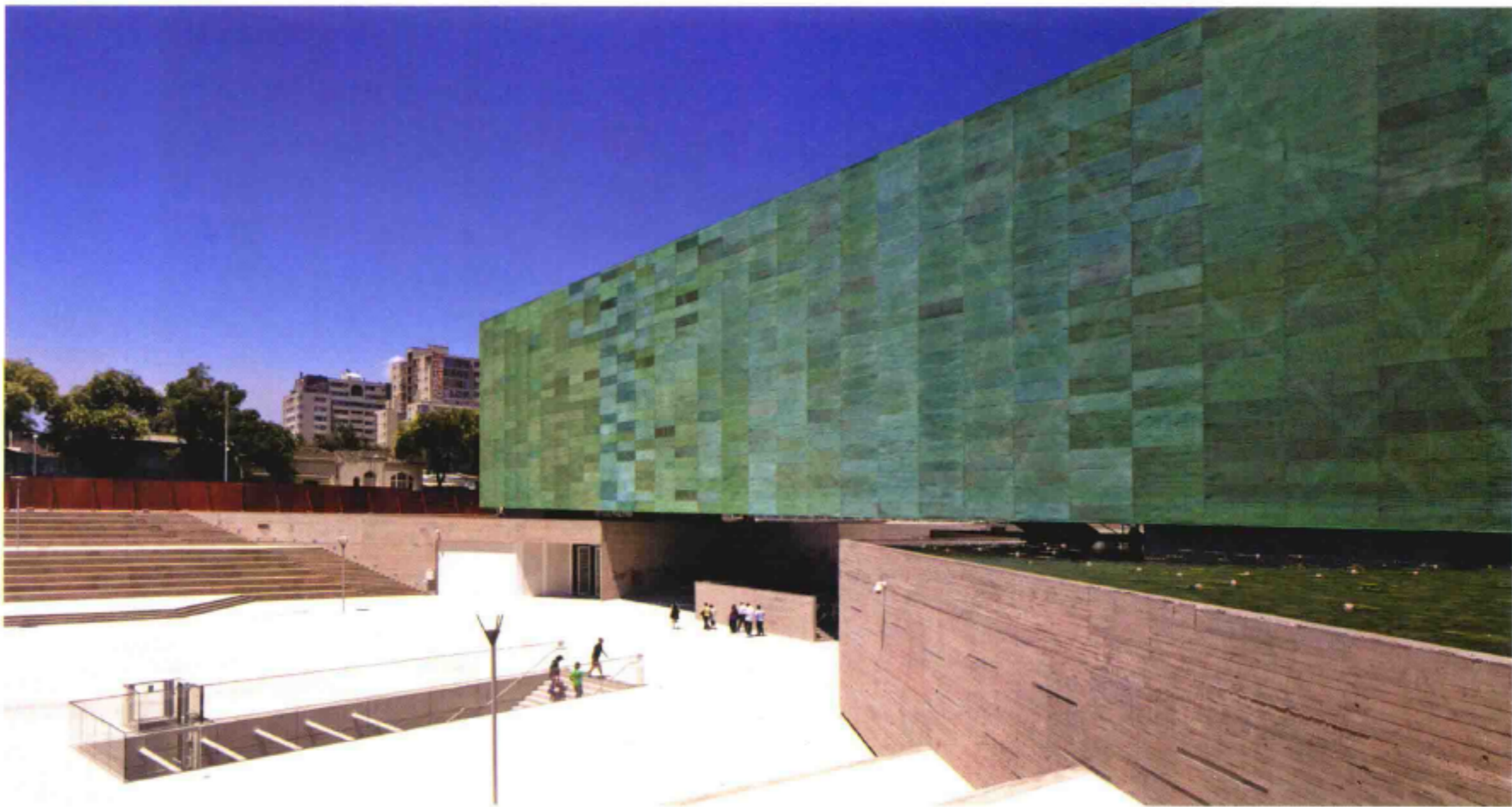
Exterior 建筑外立面
