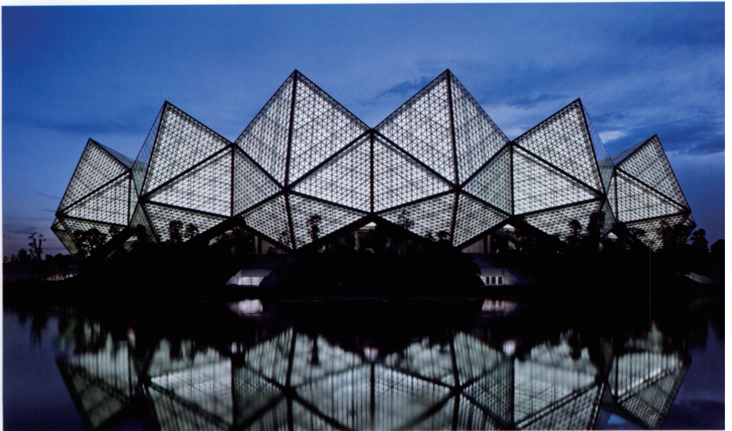
体育场立面夜景——半透明立面突出了晶体形式的外观效果
