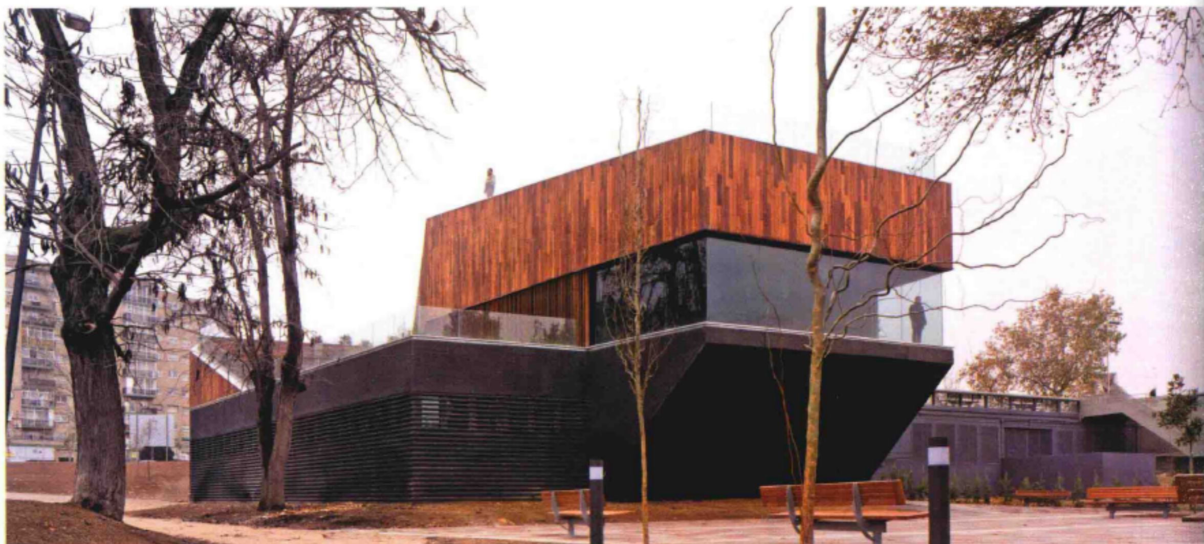
General view 全景图
