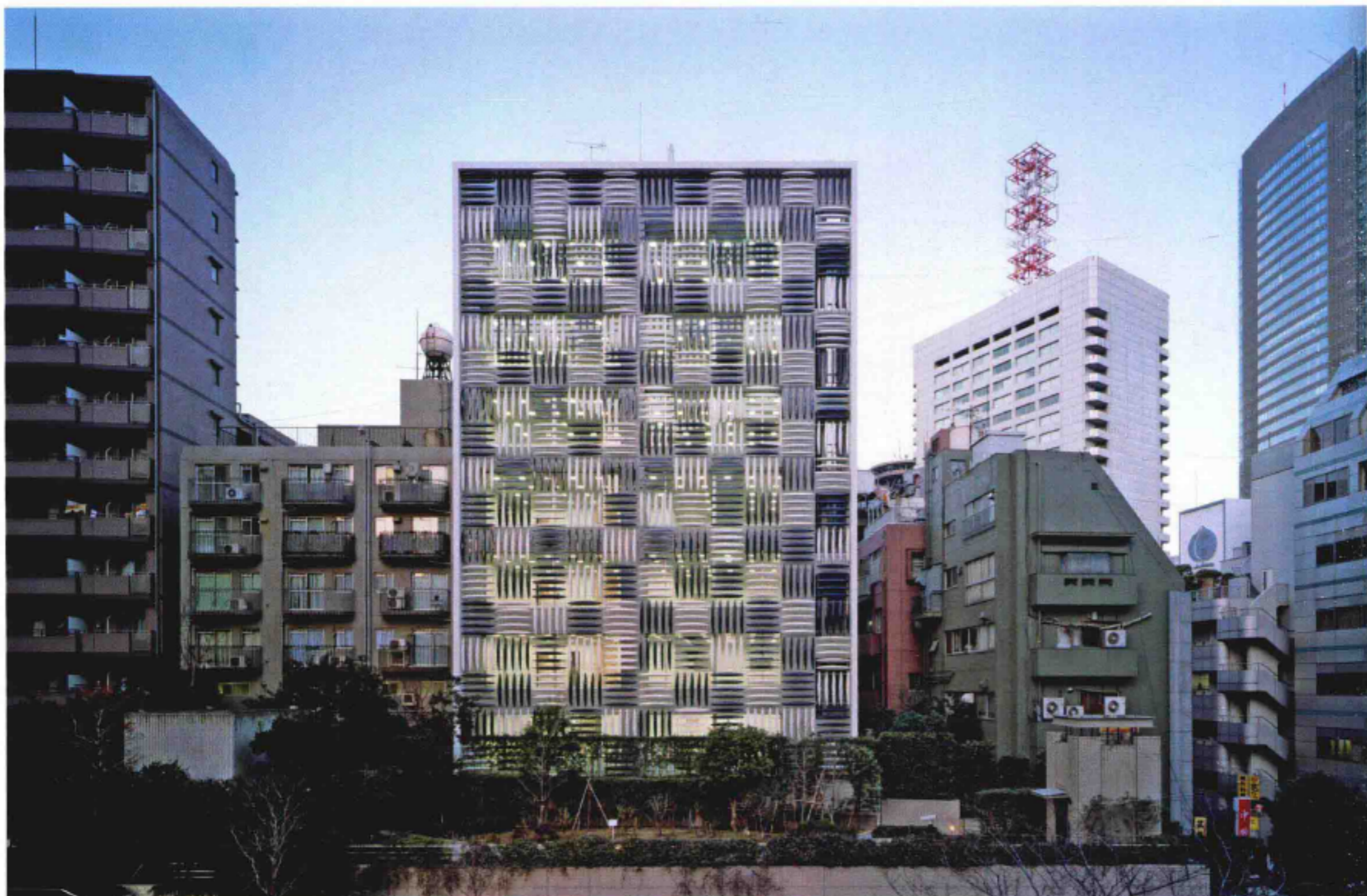
Façade 建筑外观
